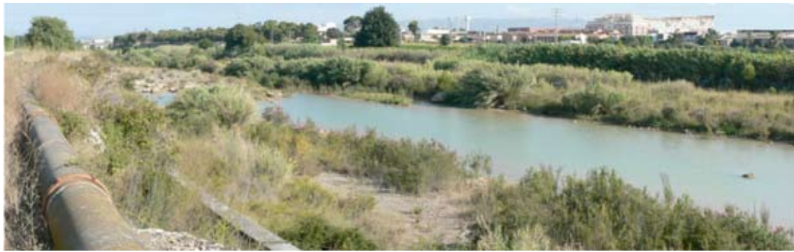
Figura 11. Vista del río Millars, con Almassora al fondo. En primer plano, conducción que transporta las aguas captadas en el Azud de Burriana (al fondo a la izquierda) que tiene su origen en el siglo XIII.
