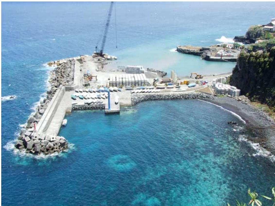
Figura 6. La nueva estructura en forma de T de Puerto Espíndola, en construcción a inicios del XXI vista desde el acantilado al norte. En realidad es una prolongación del muelle del XIX y de su rompeolas sobre la baja. Al fondo de observa el muelle antiguo sobre la antigua Punta de Espíndola. Frente al dique transversal se identifican dos pequeños roques restos de la baja de Espíndola que se extendía desde el pie del acantilado y que es la base de esta obra.
