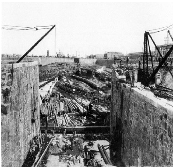
Fig 3. Construcción de Puerto Madero. Foto Pedro Repetto.
