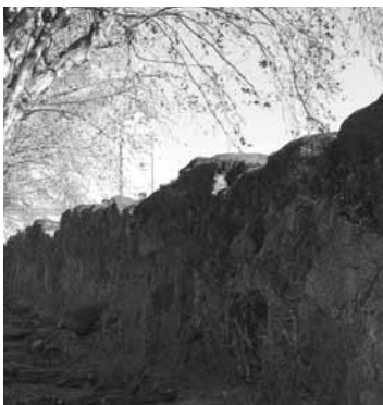
Alta Gracia: traspatio o patio de labor. Detalle muro, carpintería, herrería, boveda y muro tajamar.
