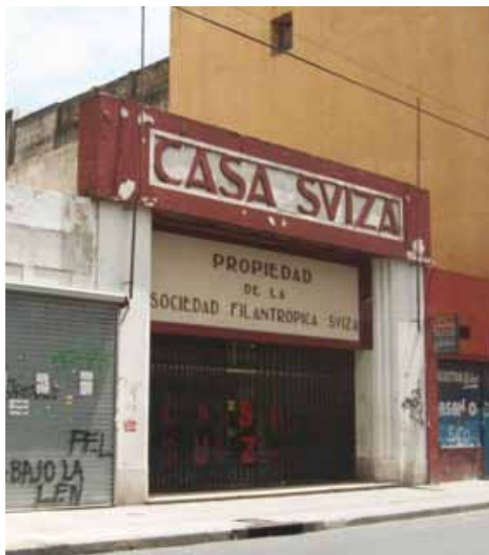
Imagen de la casa Suiza actualmente en peligro de demolición.
