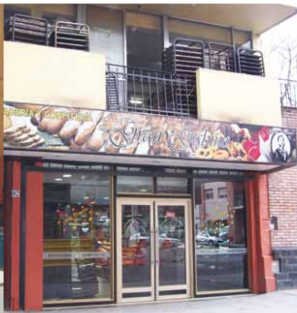
Casa de la calle Azul
