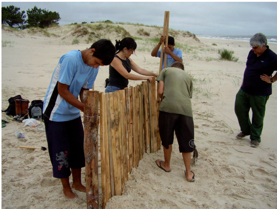
Vecinos de Ciudad de la Costa (Canelones), colocando pantallas de madera para la recuperación del ecosistema dunar (Fuente: Inti Carro)
