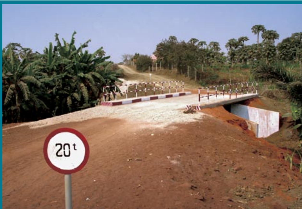
VISTA DE UMA PEQUENA PONTE DE ACESSO À UMA ÁREA RURAL, REABILITADA PELO FAS
