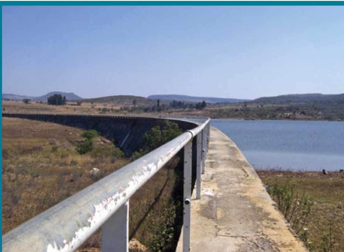
CANAL DE IRRIGAÇÃO DA HUMPATA - HUILA, RECENTEMENTE RESTAURADO PELO GOVERNO VISANDO A REVITALIZAÇÃO DO SECTOR AGRÍCOLA
