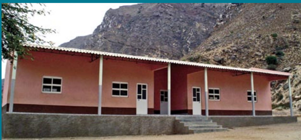
ESCOLA PRIMÁRIA CONSTRUÍDA PELO FAS
