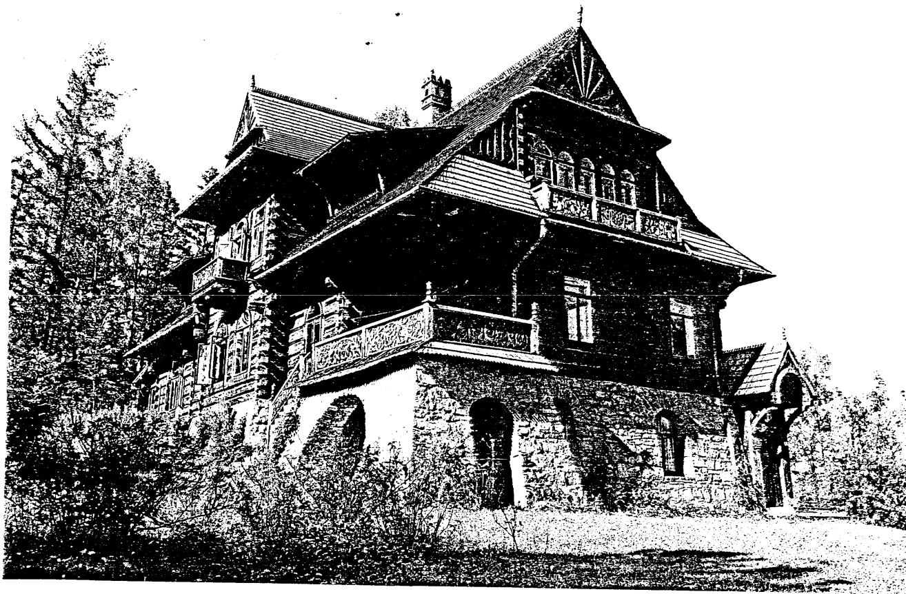
41) Stanislaw Witkiewicz, house «Pod Jedlami», Zakopane, Poland, 1897. Photo J. Świdorski.
