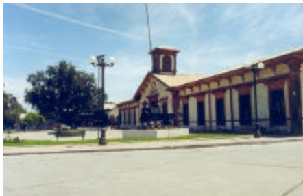
Sector Estación FFCC Copiapó , entorno Monumento Histórico Foto: Javier Marín
