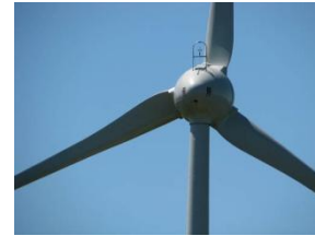
Figura #30. Rotor de la turbina eólica Enercon E44
