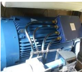
Figura #25. Motor/Generador de una turbina eólica Vestas
