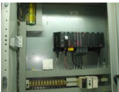
Figura #7. PLC de control maestro en una turbina
