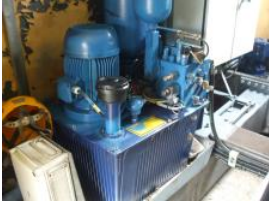
Figura #23. Sistema hidráulico de control proporcional en una turbina eólica
