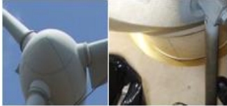
Figura #12. Cono frontal de una turbina eólica
