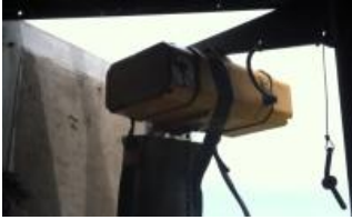
Figura #29. Grúa para el alzado de cargas en la góndola de una turbina V650
