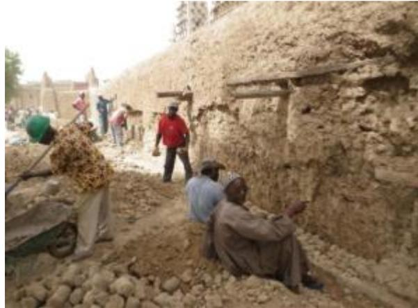
*Briques traditionnelles dites Djenné Ferey, fabrication puis mise en œuvre (mur d'enceinte)*
