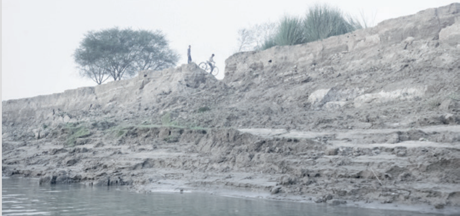
Двое мужчин осторожно передвигаются по краю обвалившегося берега.
