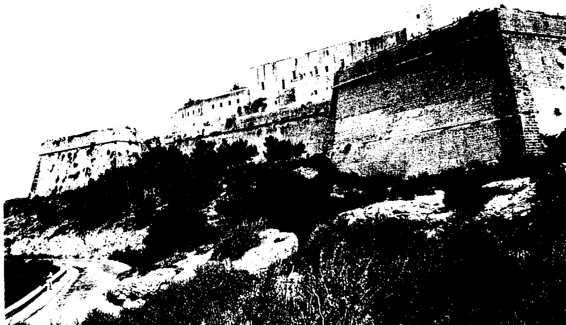
Vista general de los baluartes y el lienzo de muralla del lado sur del recinto fortificado
