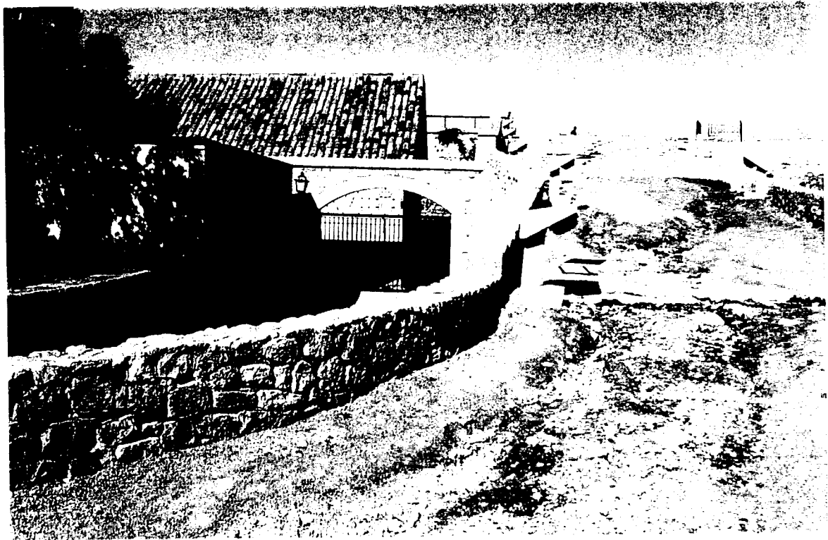
Acceso al edificio del Polvorín
