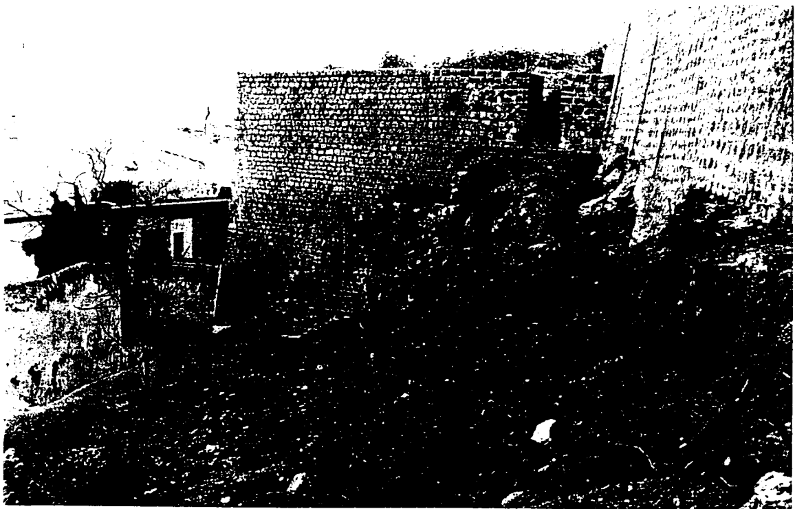
1992-1993. El Revellín después de los trabajos de restauración (7)
