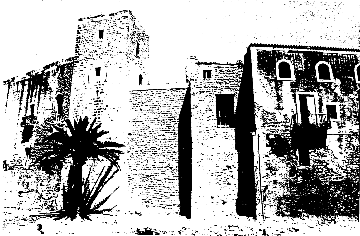
Fachada sur de la torre del Homenaje
