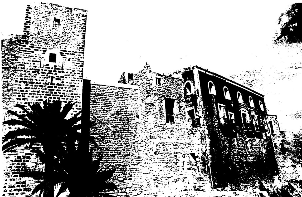
Fachada sur de la casa del Gobernador
