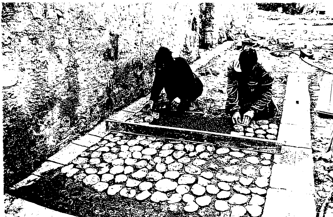
1993. Transcurso de los trabajos de pavimentación de las calles de la Santa Faz y de San Luis (8)
