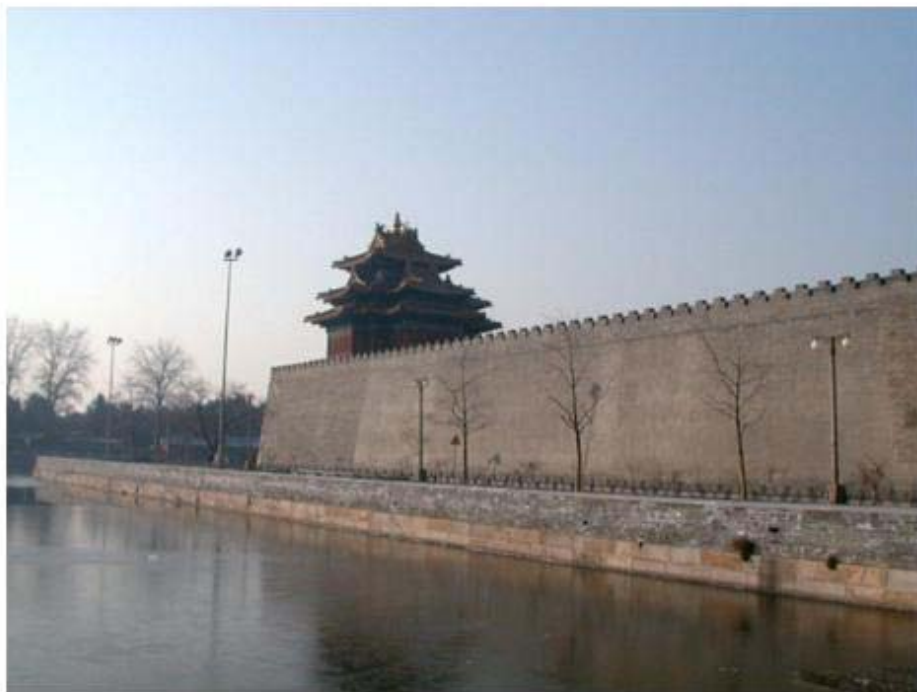
东南角楼（现状）
