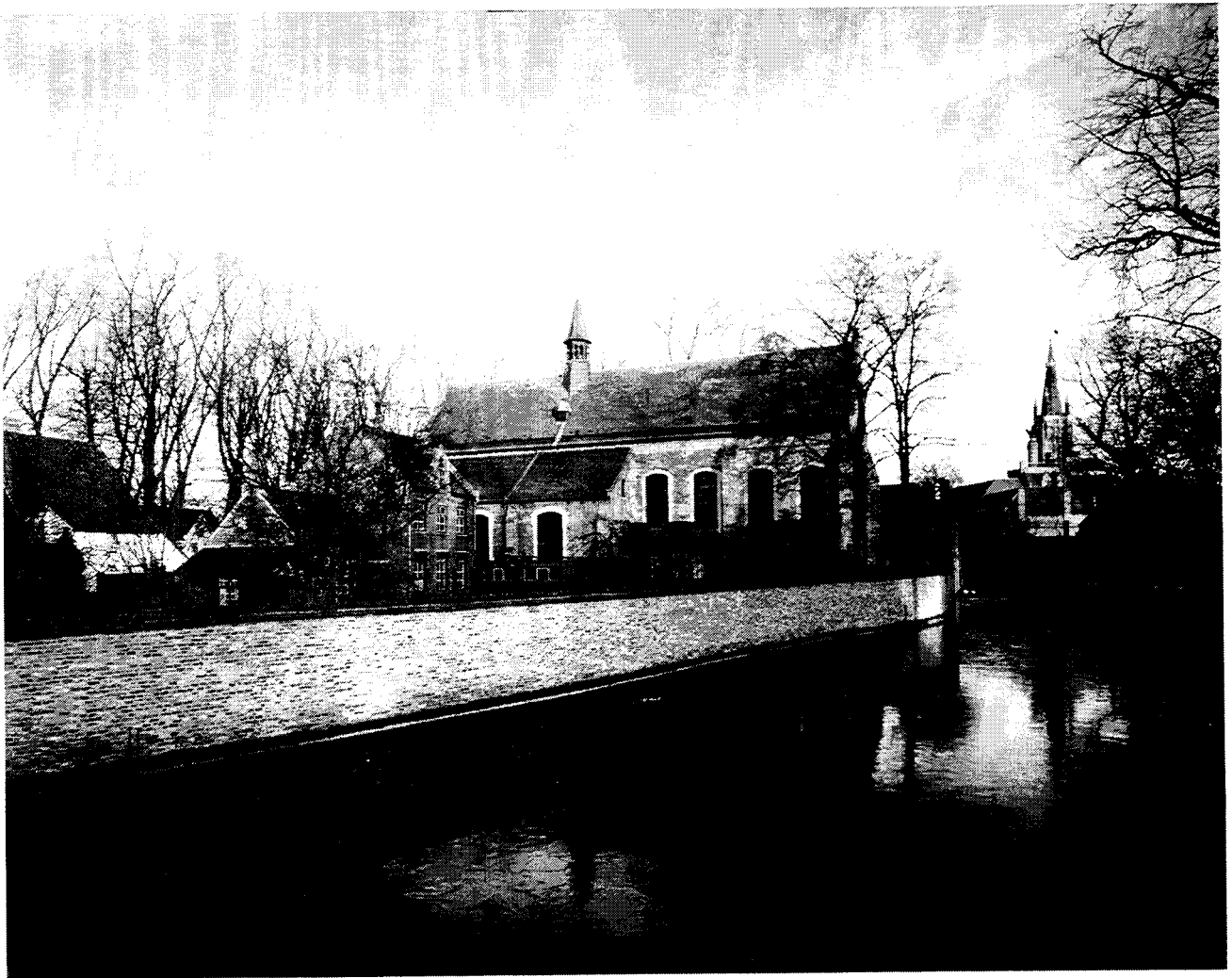
Les béguinages flamands / The Flemish béguinages : Béguinage de Bruges, église Sainte Elisabeth / Béguinage of Bruges, St Elizabeth Church
