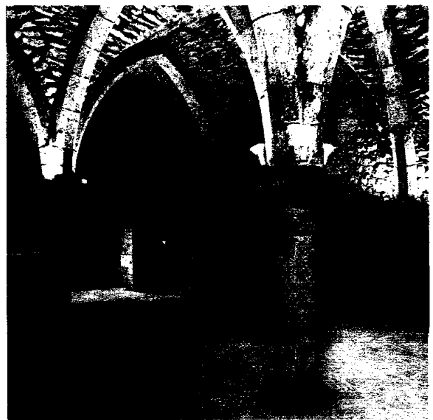
Caveau au 46, rue de Jouy.
