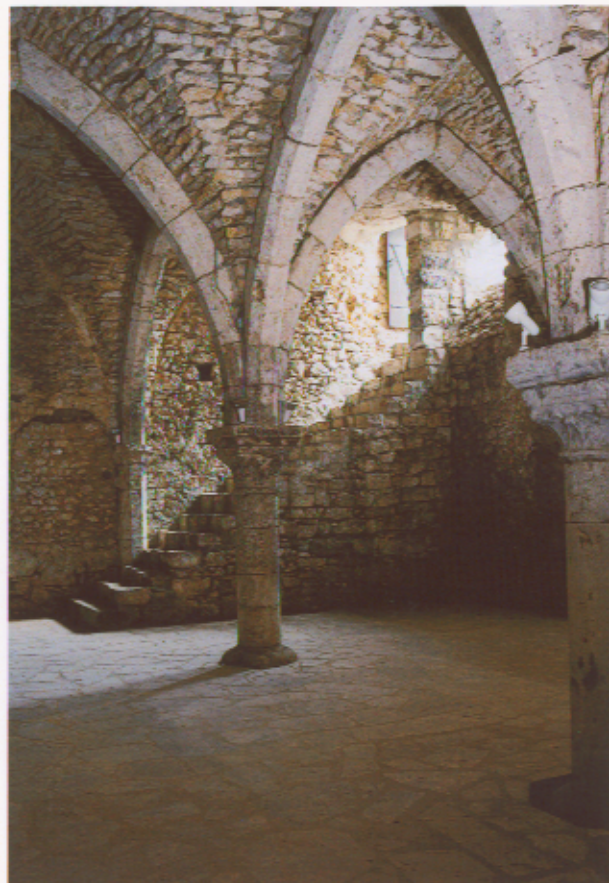
Caveau au 46, rue de Jouy.
