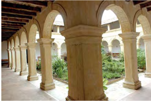
Convento São Francisco – Detalhe da nave principal
