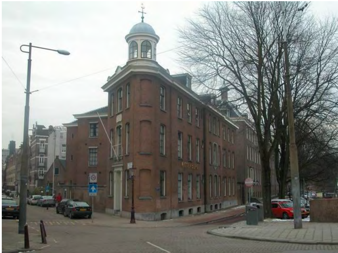
Photo C.27: View of the former Nieuwe Lutherse Diaconie , corner Nieuwe Kerkstraat, Nieuwe Keizersgracht
