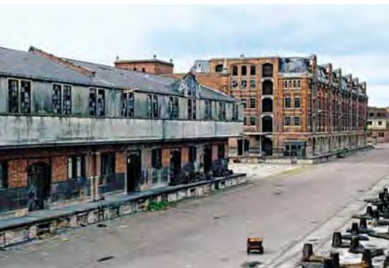
Abb. 7: Verfallene Dahlerup-Lagerhäuser auf der Ostmole (1990)
