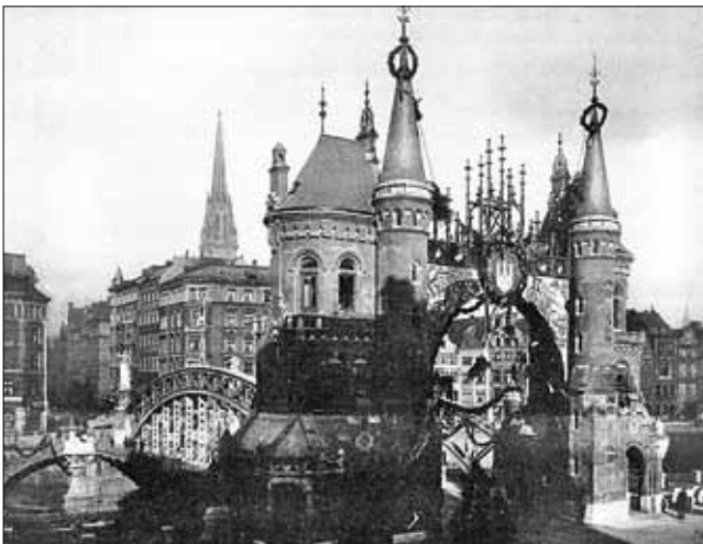
Abb. 2: Franz Andreas Meyer, Portal der Brooktorbrücke über den Zollkanal der Speicherstadt , 1888
