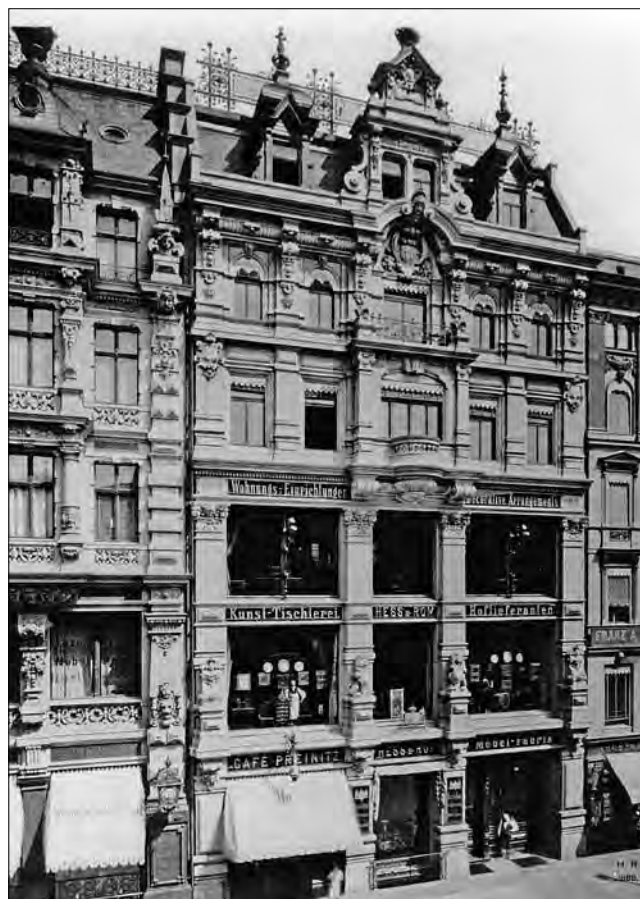
Abb. 1: Berlin, Geschäftshaus, Leipziger Straße 106, Fassade, zerstört (Aufnahme 1888)
