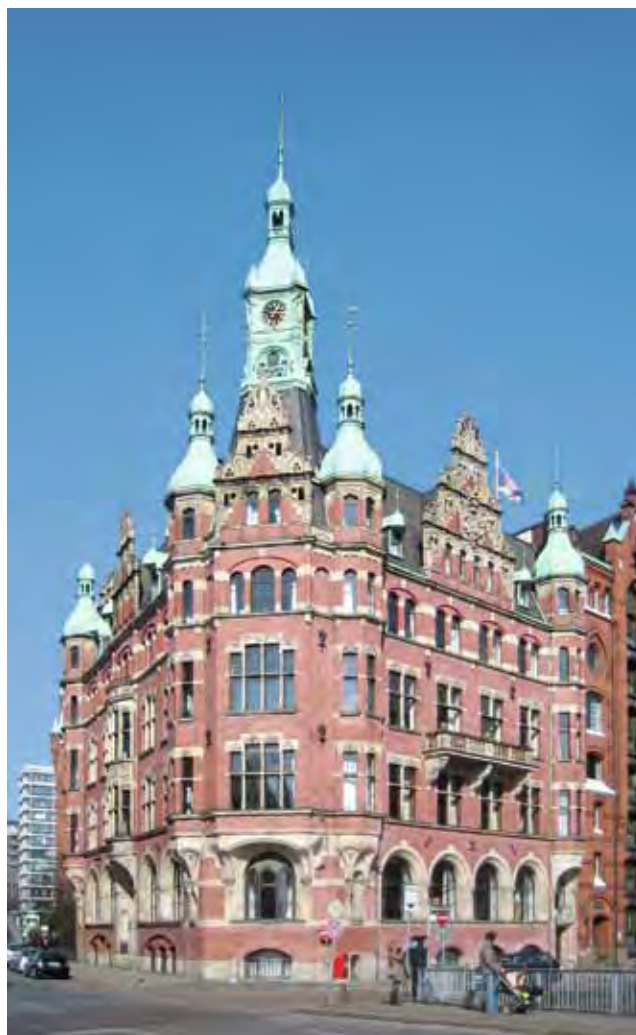
Abb. 10: Das zweite Verwaltungsgebäude der HFLG von Hanssen & Meerwein und Johannes Grotjan (1902–04)
