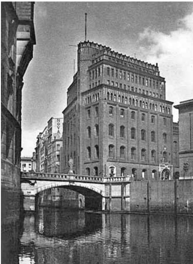
Abb. 1: Theodor Bühlau, Patriotische Gesellschaft 1844–47, Aufstockung 1924 durch Erich zu Putlitz (Klophaus/Schoch /zu Putlitz)
