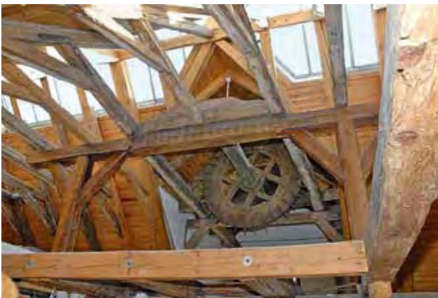
Abb. 8: Bremen, Vegesack, Lange-Speicher, 1805, Innenkonstruktion mit Winde
