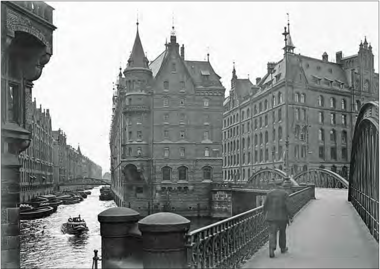
Abb. 5: Hannoversche Schule: Block G (Mitte) und Block H (rechts) von Georg Thielen (1886/87 bzw. 1887/88, Aufnahme 1932). Block G wurde 1943 zur Hälfte zerstört. Heute steht hier die Kaffeebörse (vgl. Abb. 13)
