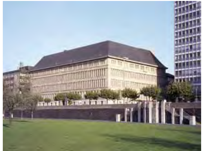
Abb. 1: Peter Behrens, Mannesmann Verwaltungsgebäude, Düsseldorf, 1911/12
