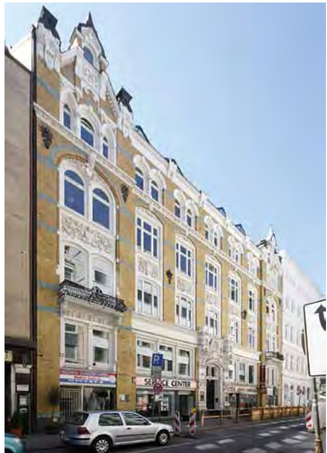
Abb. 6: Kontorhaus Feigl, 1899, Architekt Walter Martens
