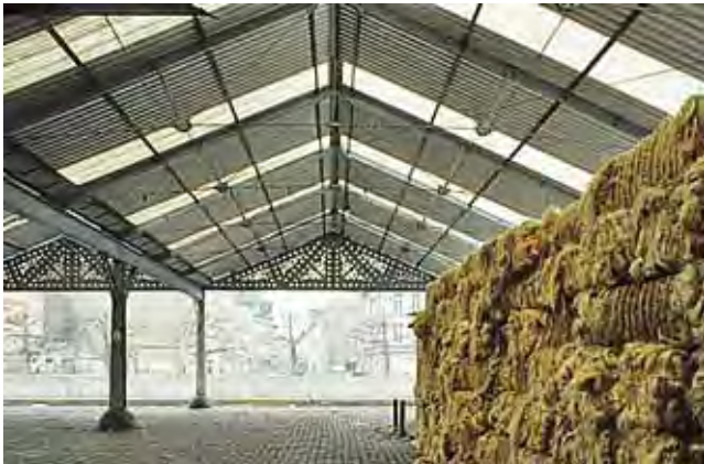
Abb. 9: Die eisernen Lagerschuppen entlang des 1877–1988 erbauten Scheldekais
