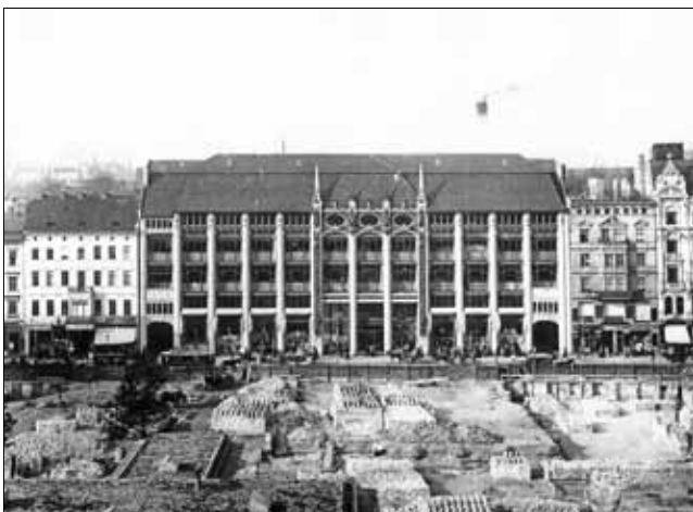
Abb. 4: Berlin, Warenhaus Wertheim, Leipziger Straße 132–133, Fassade mit Baustelle des Preußischen Herrenhauses [heute Bundesrat] im Vordergrund, zerstört (Aufnahme 1898)
