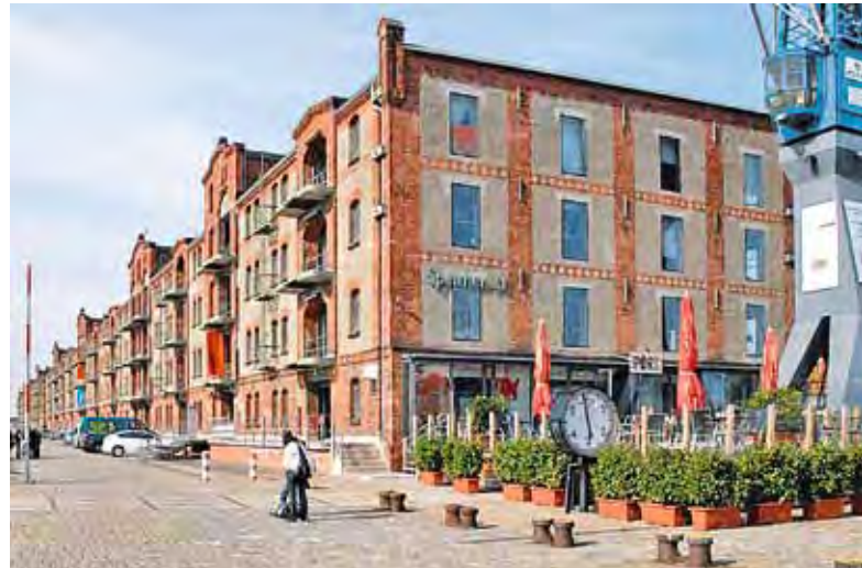
Abb. 9: Bremen, Überseestadt, Speicher 11
