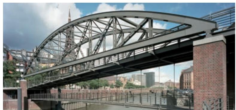
Fig. 15: The modern Kibbelstegbrücke
