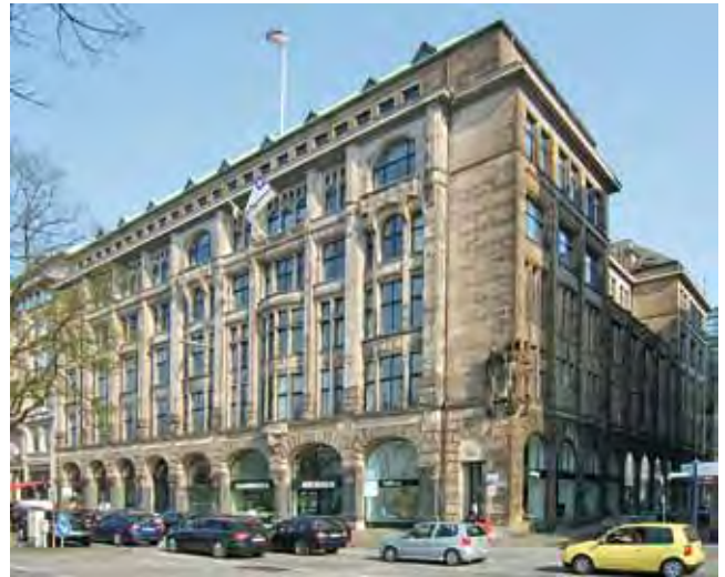
Abb. 10: Kirdorfhaus, 1901–05, Architekten Lundt & Kallmorgen
