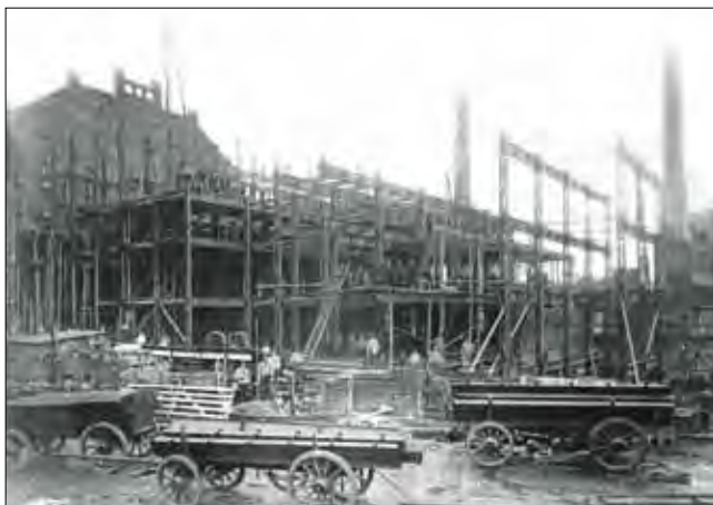
Abb. 9: Block E von Georg Thielen im Bau (um 1888). Die Stahlelemente wurden vorgefertigt an die Baustelle geliefert
