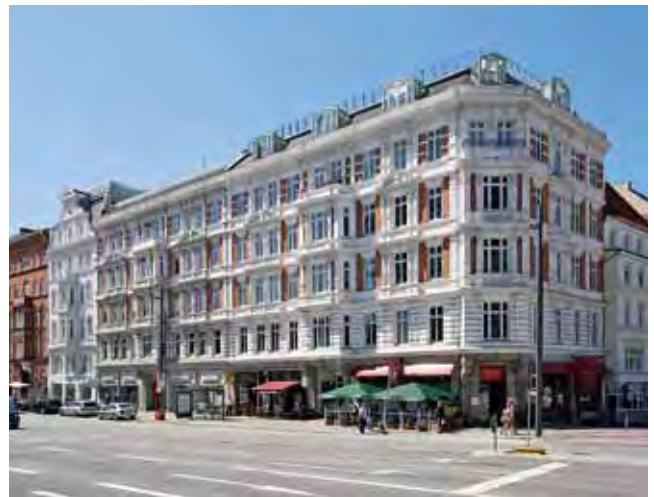
Abb. 3: Wohn- und Geschäftshaus Brandstwierte, 1886–87, Architekt Albert Heidtmann
