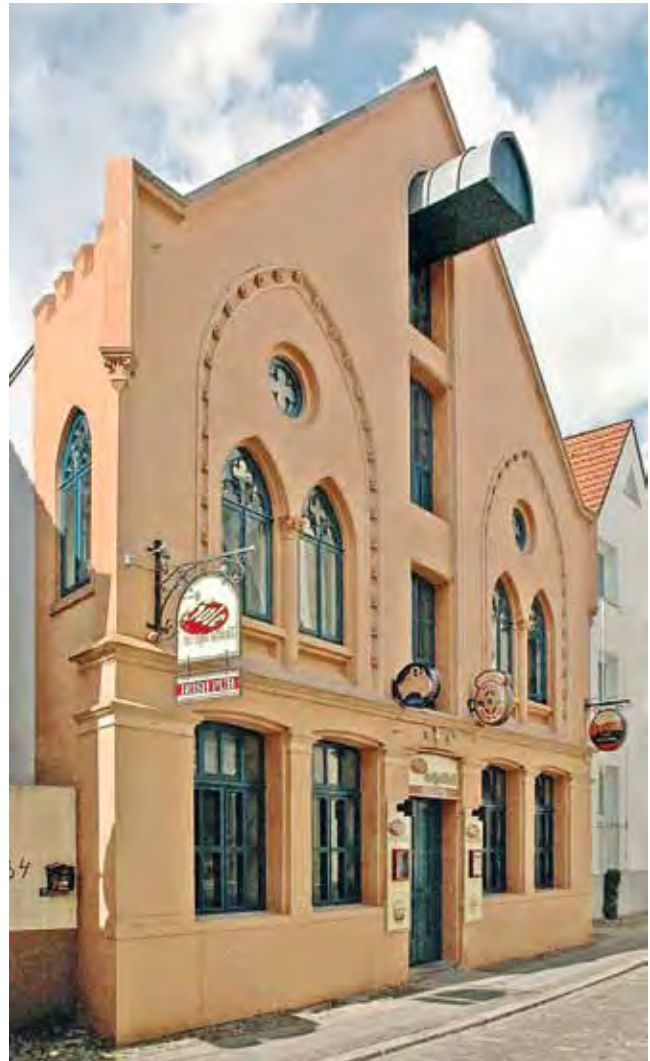
Abb. 6: Bremen, Vegesack, Speicher, Anfang 19. Jh., Fassade 1860
