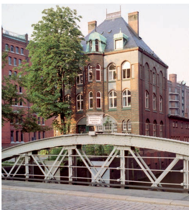
Fig. 16: Winch Operators' House (Wasserschlosschen)
