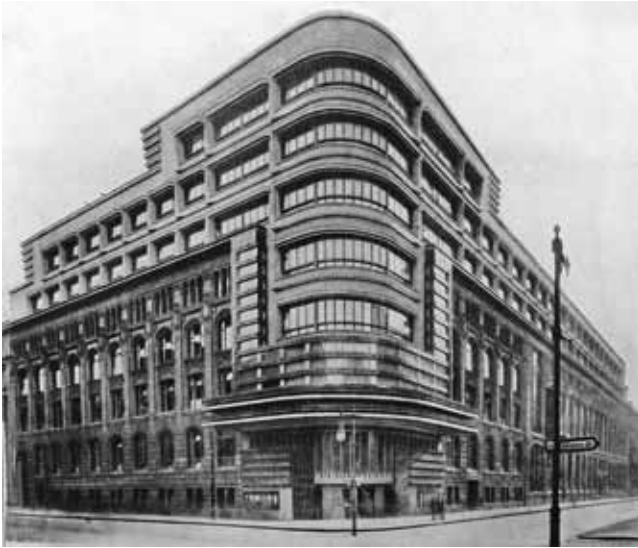
Abb. 11: Berlin, Mossehaus, Schützenstraße 18–25, Ansicht der Gebäudeecke, verändert erhalten (Aufnahme vor 1929)
