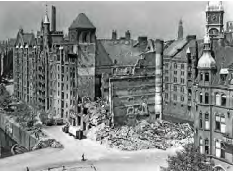
Abb. 11: Die Ruine von Block R (1944)
