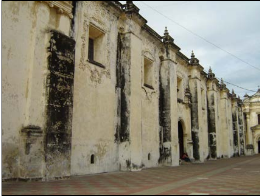
Façade latérale sud
