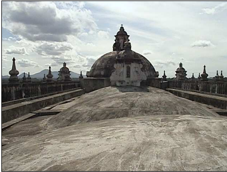
Couverture de la Cathédrale (nef centrale)
