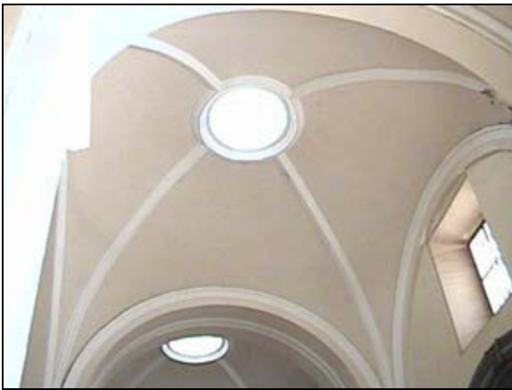
Voûte d'un collatéral
