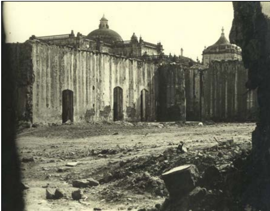
Immeubles détruits autour de la cathédrale, 1979
