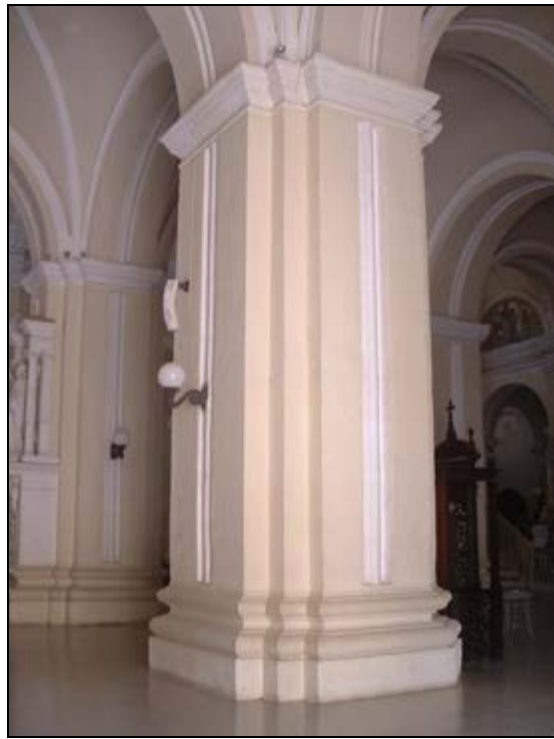
Pilier d'un collatéral
