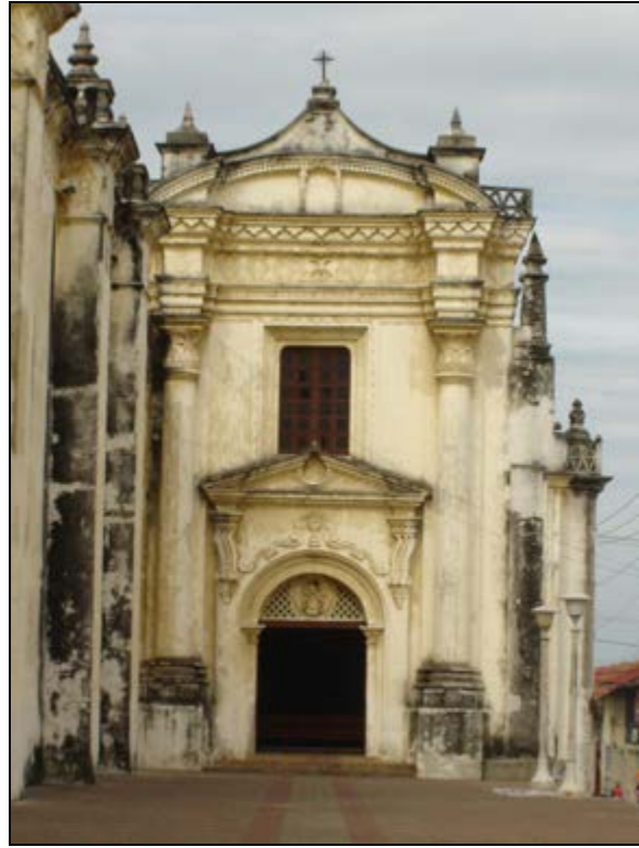
Façade chapelle du Sanctuaire
