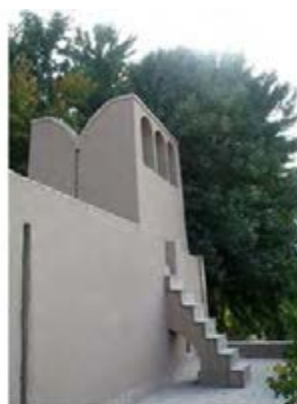
General View (2).JPG
