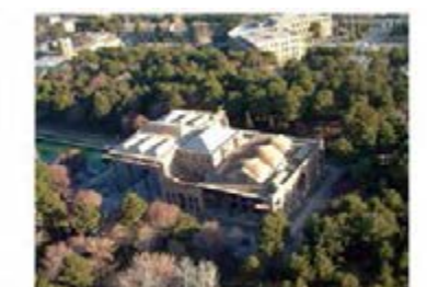
General View (9).JPG
