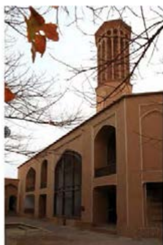
General View (13).jpg
