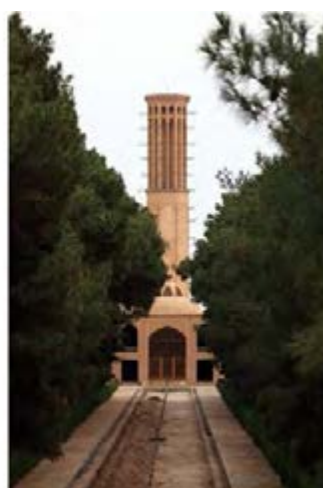
General View (15).jpg
