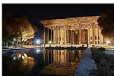
General View (8).jpg
