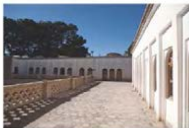
General View (4).jpg
