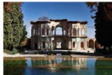
General View (3).jpg
