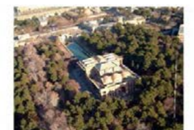
General View (10).JPG
