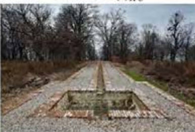
General View (8).jpg
