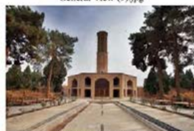
General View (12).jpg
