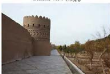
General View (11).jpg
