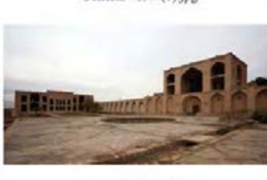
General View (9).jpg
