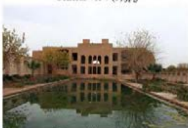
General View (8).jpg
