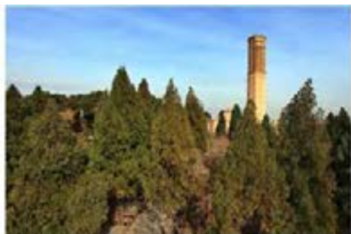
General View (1).jpg
