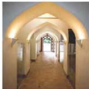
General View (7).jpg
