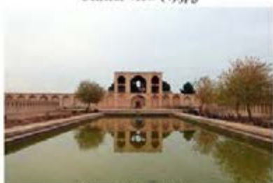
General View (7).jpg
