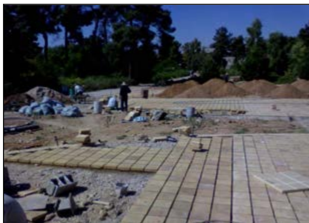
Fig.4-9.restoring the pavement (S. Malekpur)
