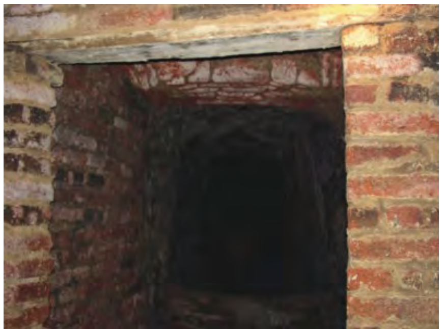
001 018 ENTRANCEWAY TO THE MINA DEL CASTILLO
