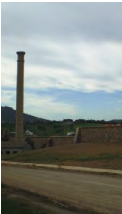
001 016 ČERMAK-ŠPIREK FURNACES. CHIMNEY
