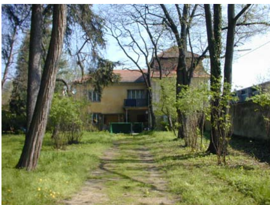
Das Nebengebäude im östlichen Eckbereich des Schlossparks wird derzeit privat genutzt.
