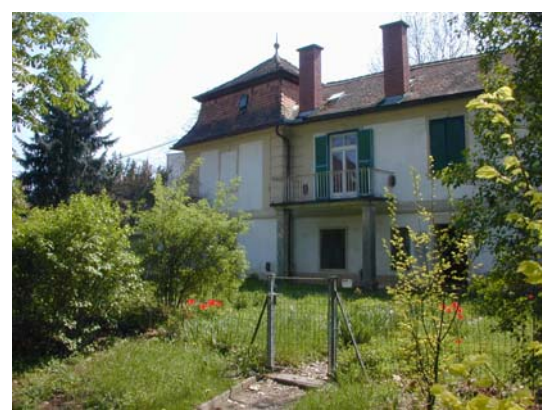
Das Nebengebäude im südlichen Eckbereich (Südpavillon) ist derzeit ohne aktuelle Nutzung.
