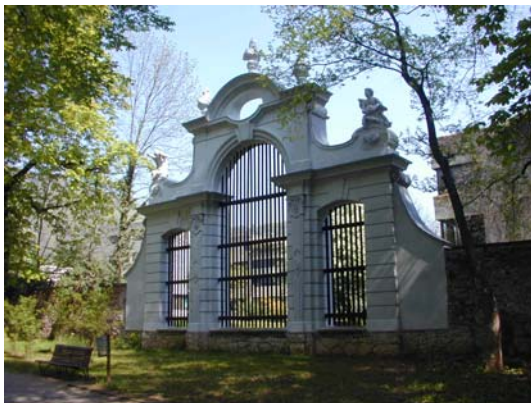
Eines der drei prächtigen Barocktore: hier an der nördlichen Gartenmauer.
