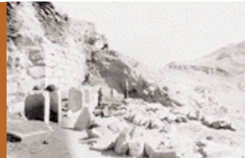
Déblaiement de la façade de bâtiments à Chavín en 1956.
