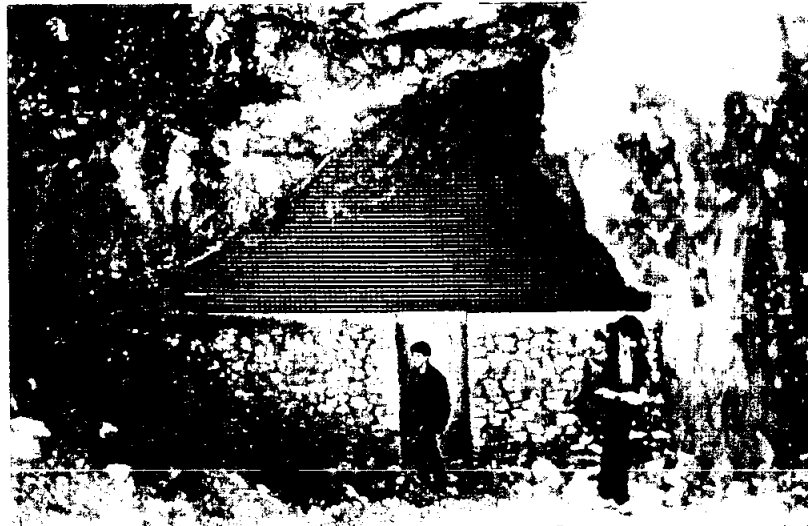
Foto 9: Cierre de Cueva del Silo (Arch. G.E.E.)
