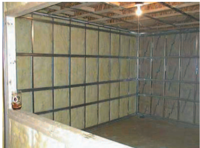
[84] Cabina insonorizada con fibra de vidrio. Trabajo realizado por http://www.masacoustics.com
