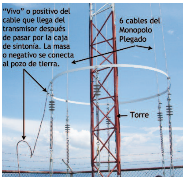
[68] Modelo de torre AM con monopolo plegado
