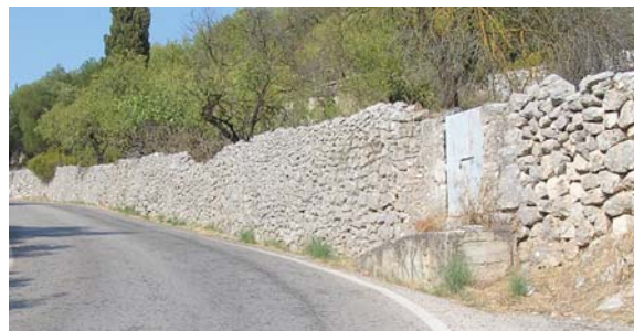
Mur de clôture en Céphalonie (Grèce)
