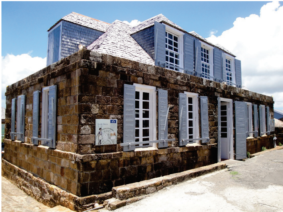
Poste de garde
