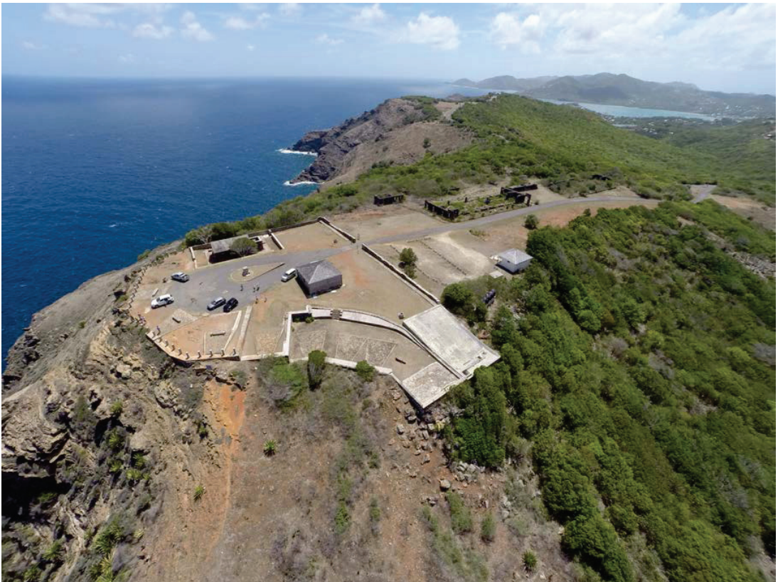
Vue aérienne du BlockHouse avec la citerne, la plateforme et le magasin de poudre
