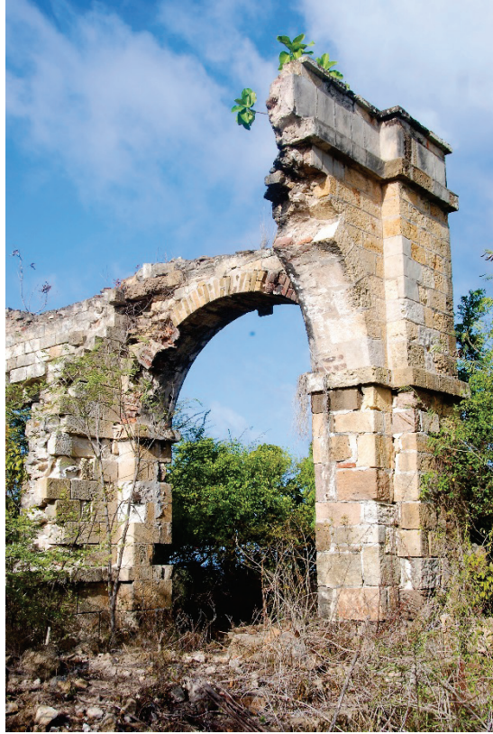
Bâtiment de l'artillerie
