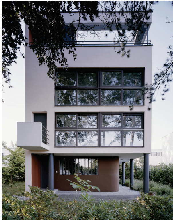
Élément 5 : Maisons de la Weissenhof-Siedlung– Stuttgart, Allemagne
