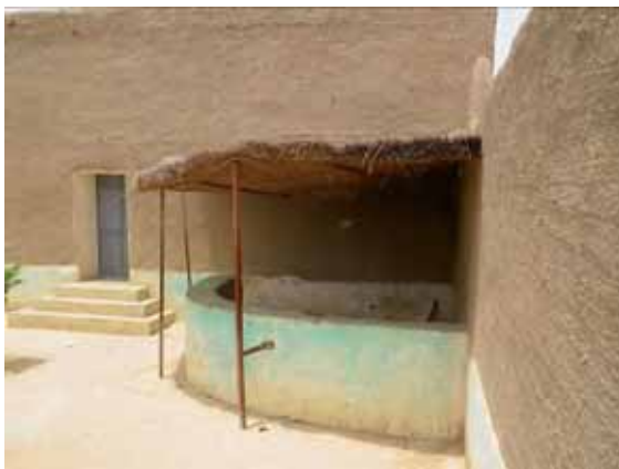
Bar et sa toiture
