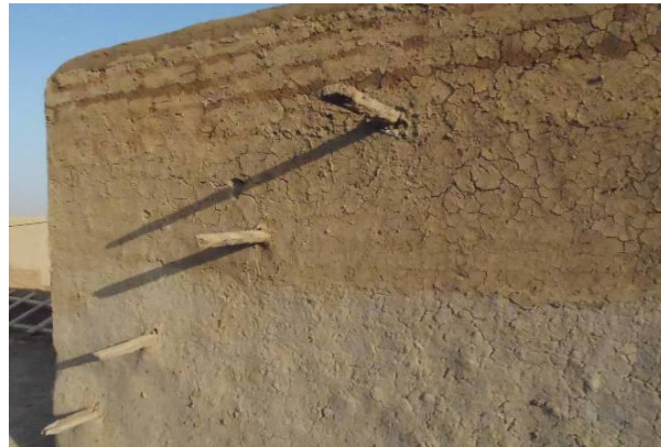
Escalier d'accès pour l'entretien
