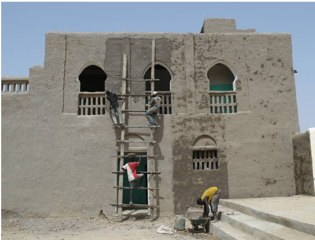
Début Octobre 2011, le dernier crépissage de finition est passé sur l'ensemble des bâtiments
