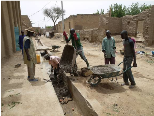
L'ancien canal a nécessité une révision complète de ses pentes
