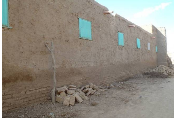
Reprise de la base du mur côté rue Sankoré
