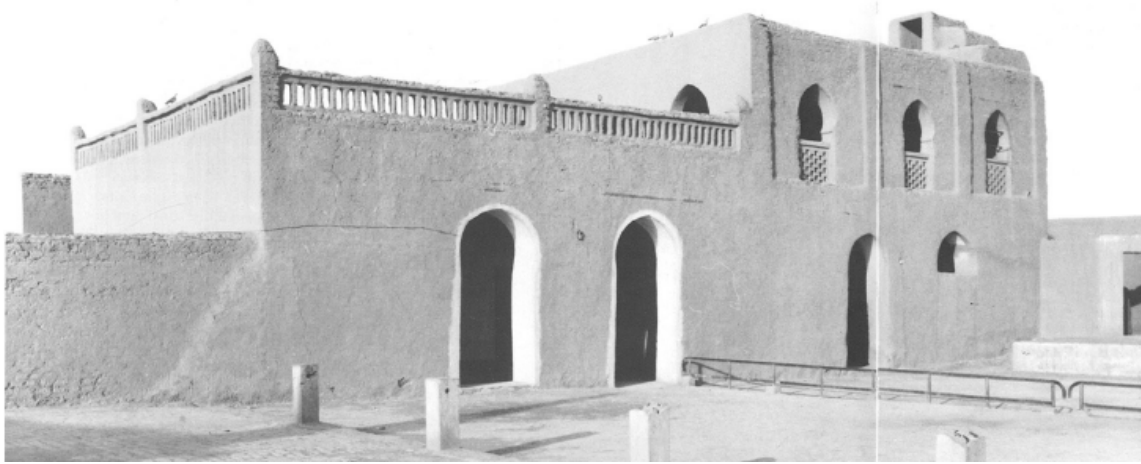
La façade initiale (vers 1980)
