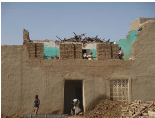
Remontage de la façade Jambages puis arcs
