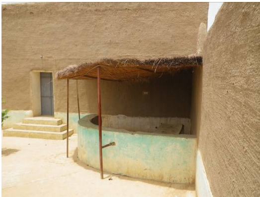
Bar et sa toiture
