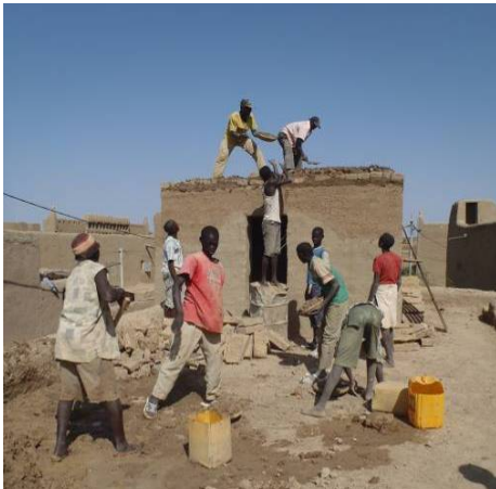
Couverture de la toilette Est
