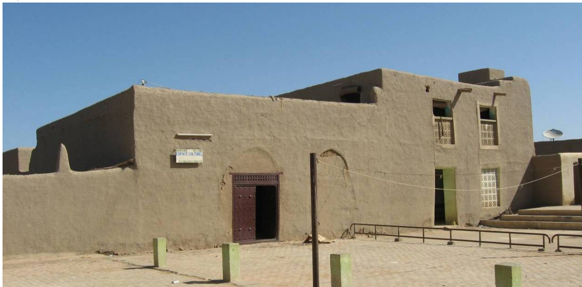
La façade en décembre 2009
