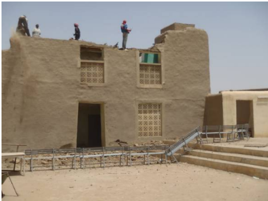
Démontage de la façade et de la toiture
