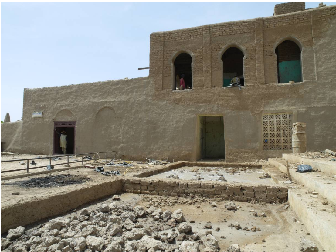
Avril 2011, la façade a déjà été reprise et on commence à penser au crépissage avec le trempage de la terre de bas fond.
