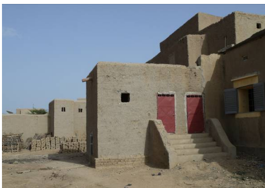
Le nouveau bloc sanitaire au niveau de la maison du peuple
