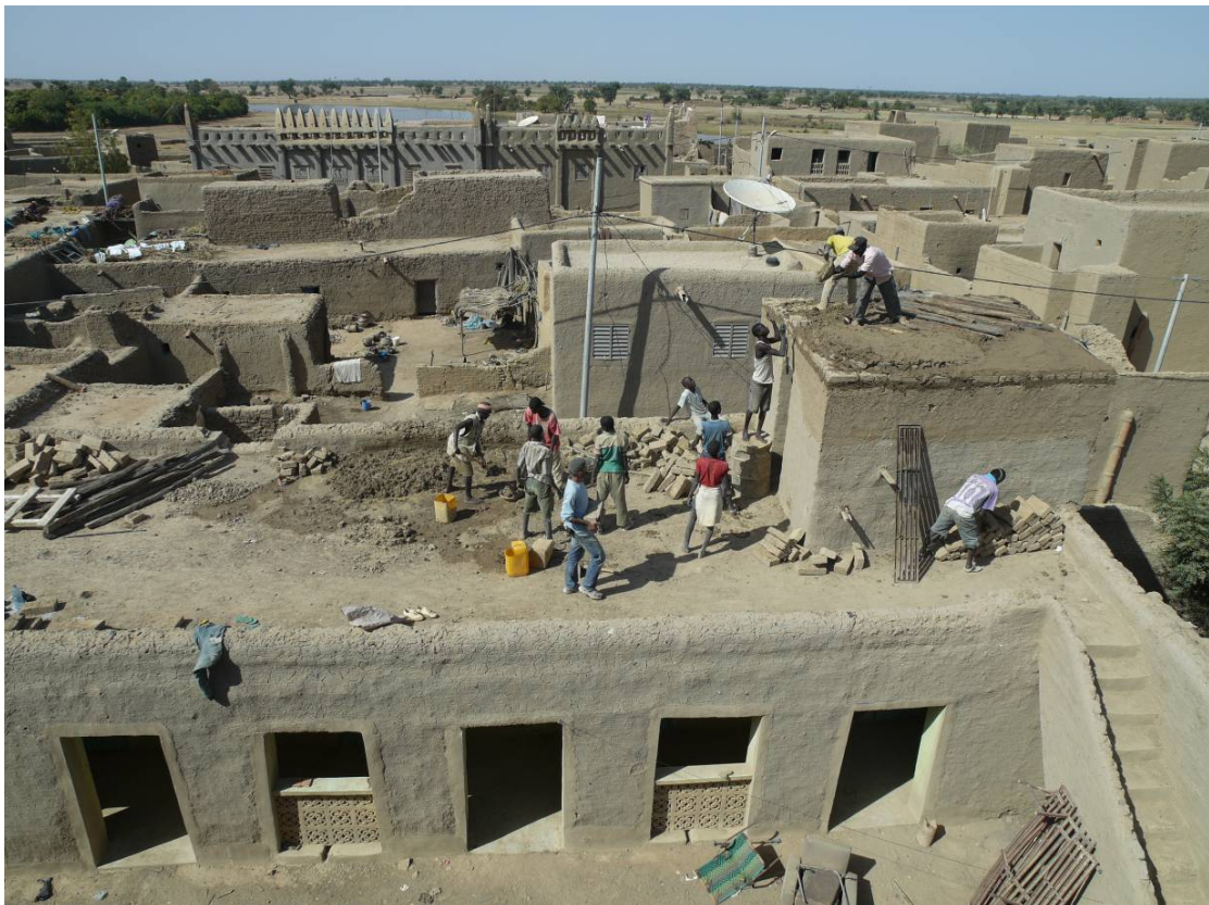
Première étape du chantier : travaux de gros œuvre sur l'annexe
