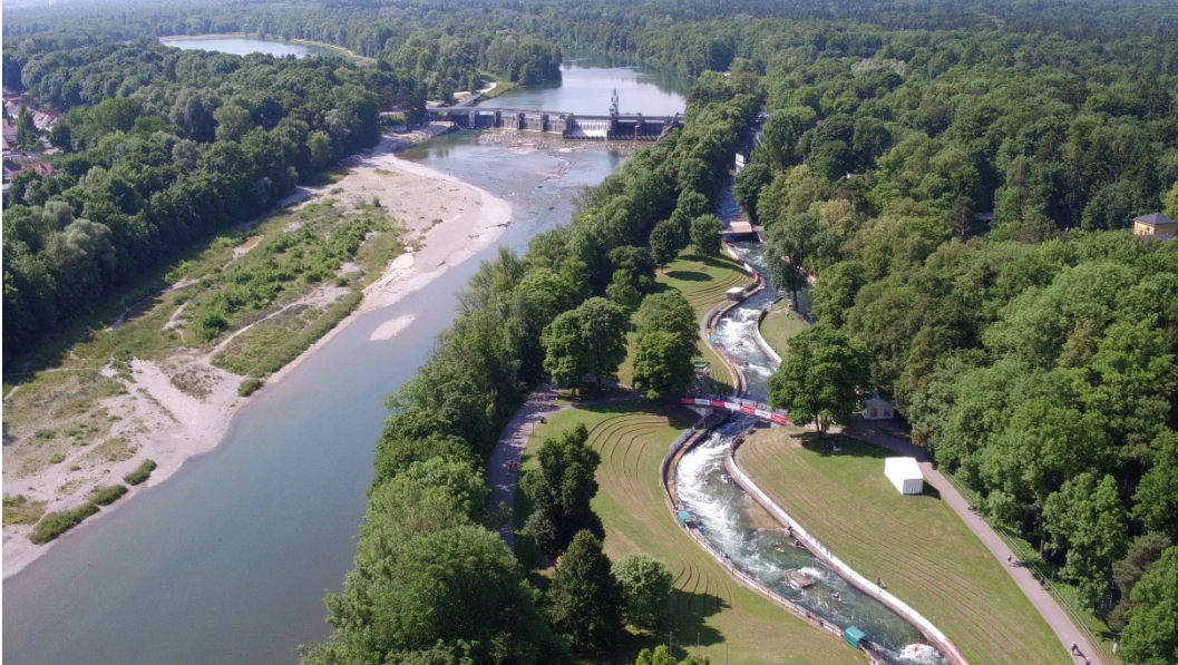
Vue aérienne de la station de pompage de Hochablass
