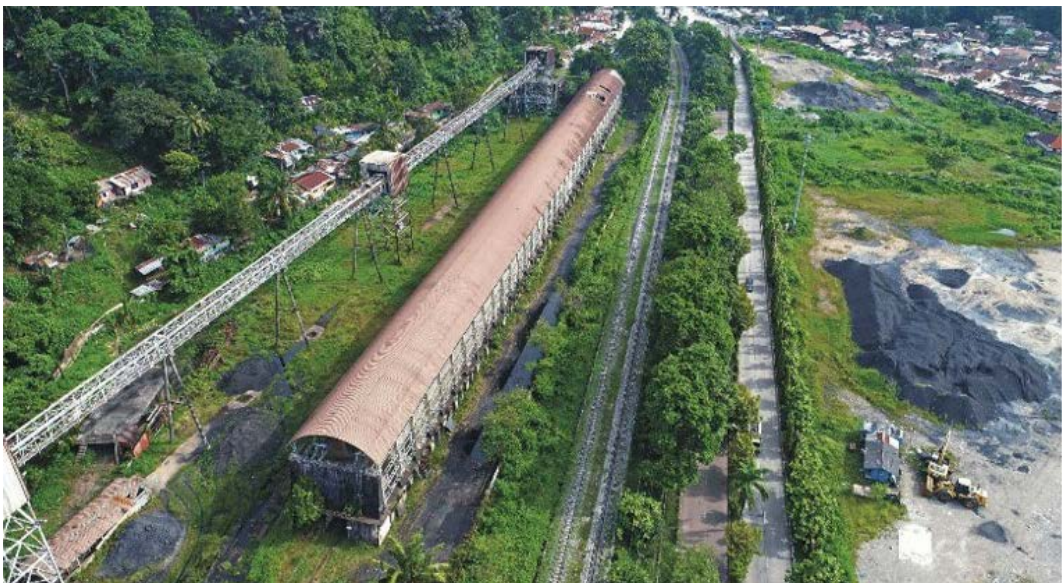
Vue aérienne des installations de stockage du charbon au port d'Emmahaven
