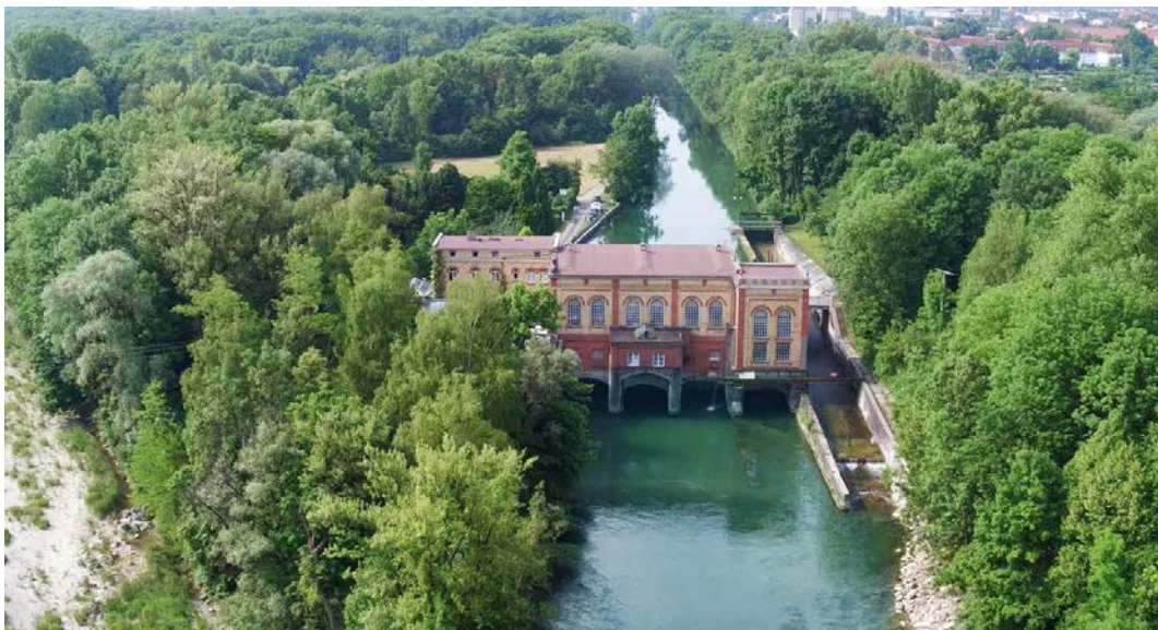
Centrale hydraulique de Wolfzahan
