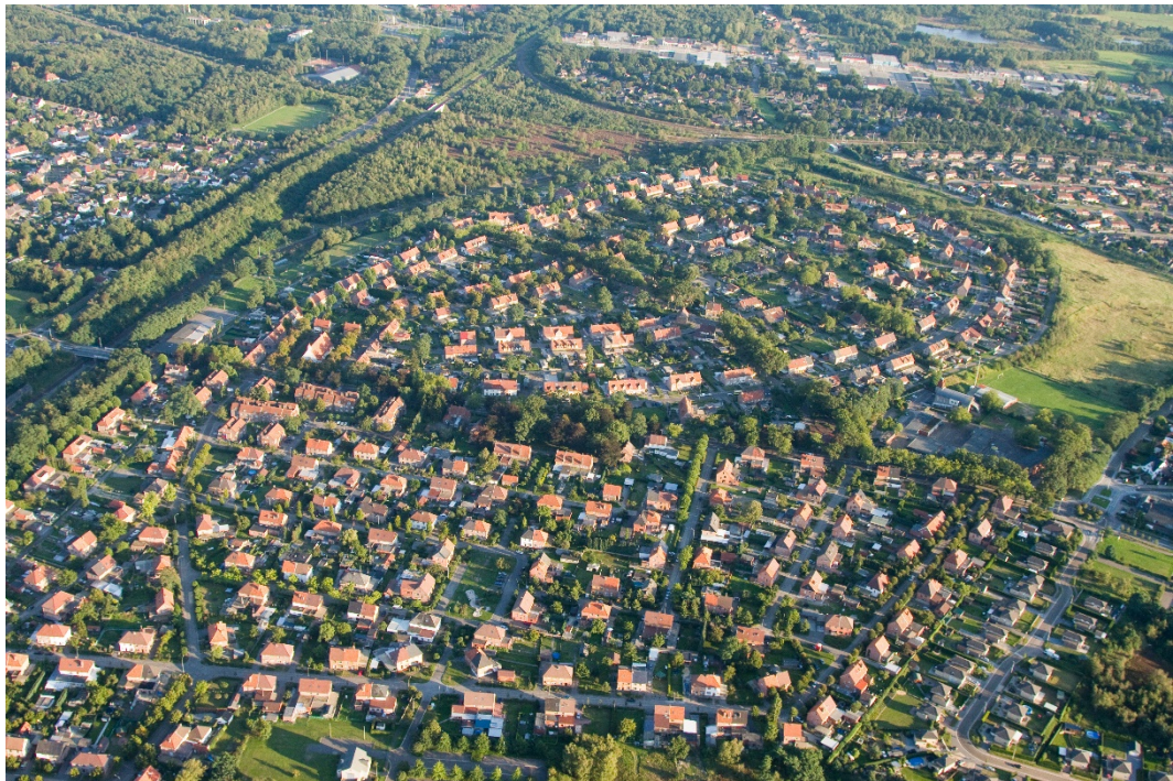
Vue aérienne – Cité-jardin de Winterslag
