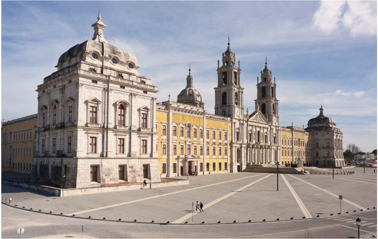
Façade principale (côté est)
