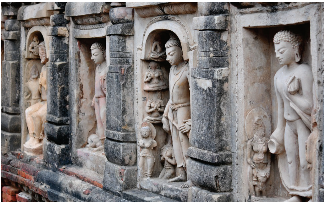
Stucco art on site n. 3
