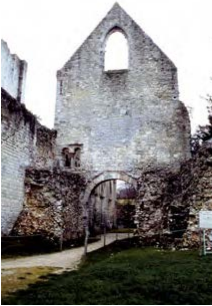
... les ruines du porche
