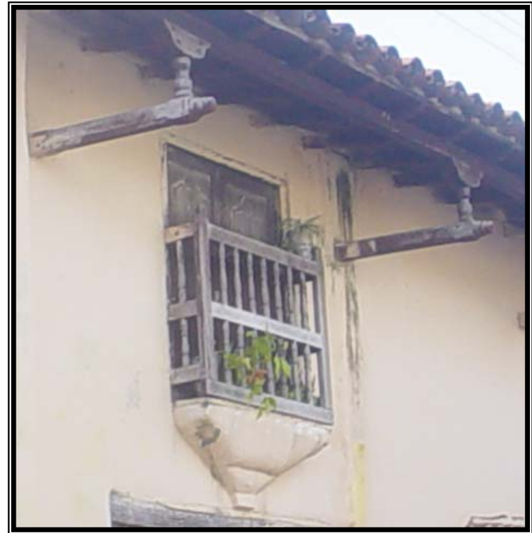
DETALLE DEL CUARTO ESQUINERO
