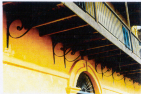
24- Balcon vu de dessous
