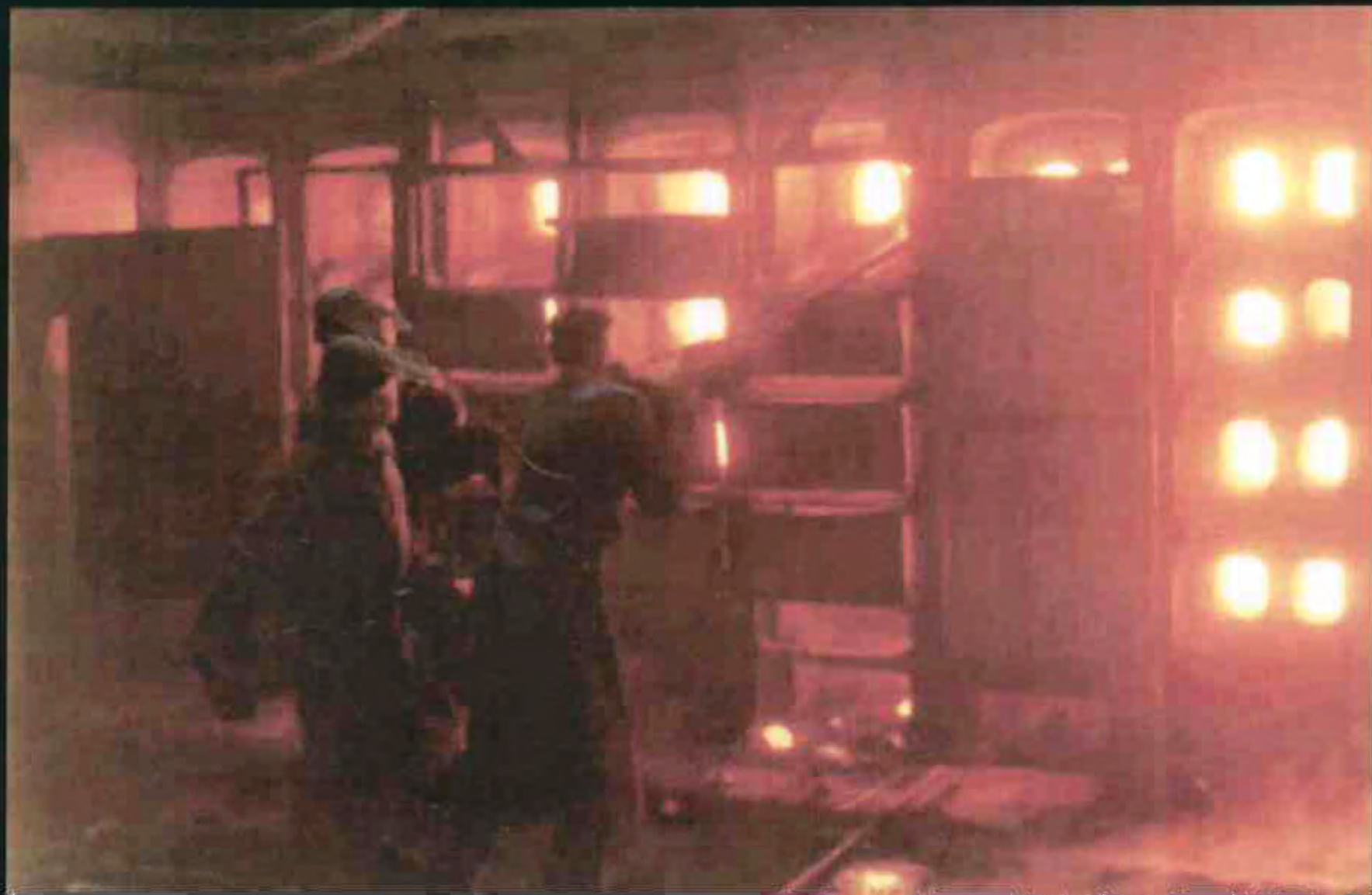
78. Le remplacement des creusets était une des étapes les plus complètes dans le processus de réduction du zinc. Il n'a jamais pu être mécanisé.
