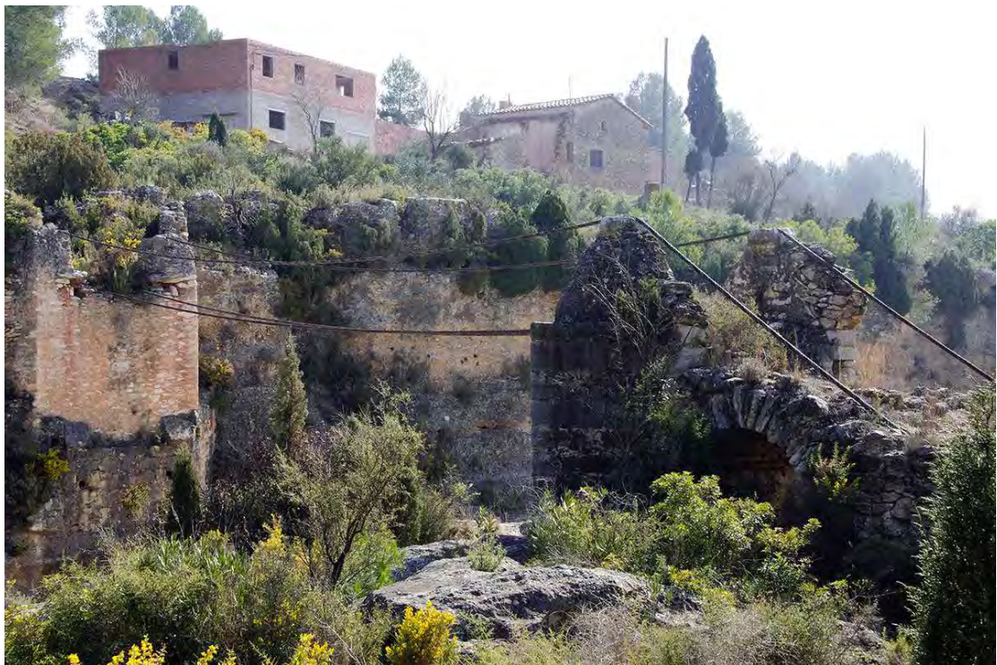
Antic pont de fusta sobre el riu Monlleó
