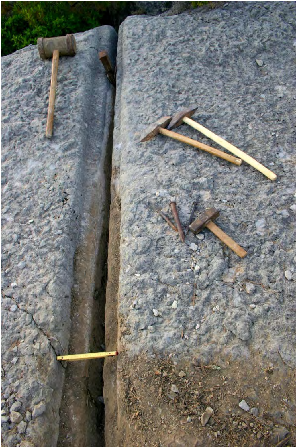
Tasconera feta a una roca per obrir-la, i ferramentes (maça, tascons, pics de pedrapiquer, maceta i punxons...)
