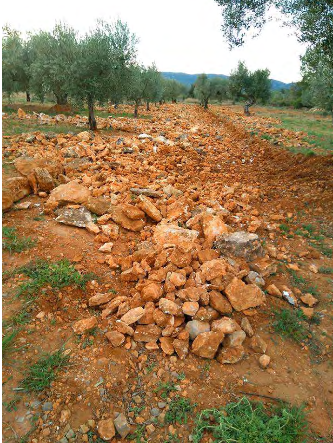
EXTRACCIÓ DE PEDRA SECA D'UN BANCAL D'OLIVERES
