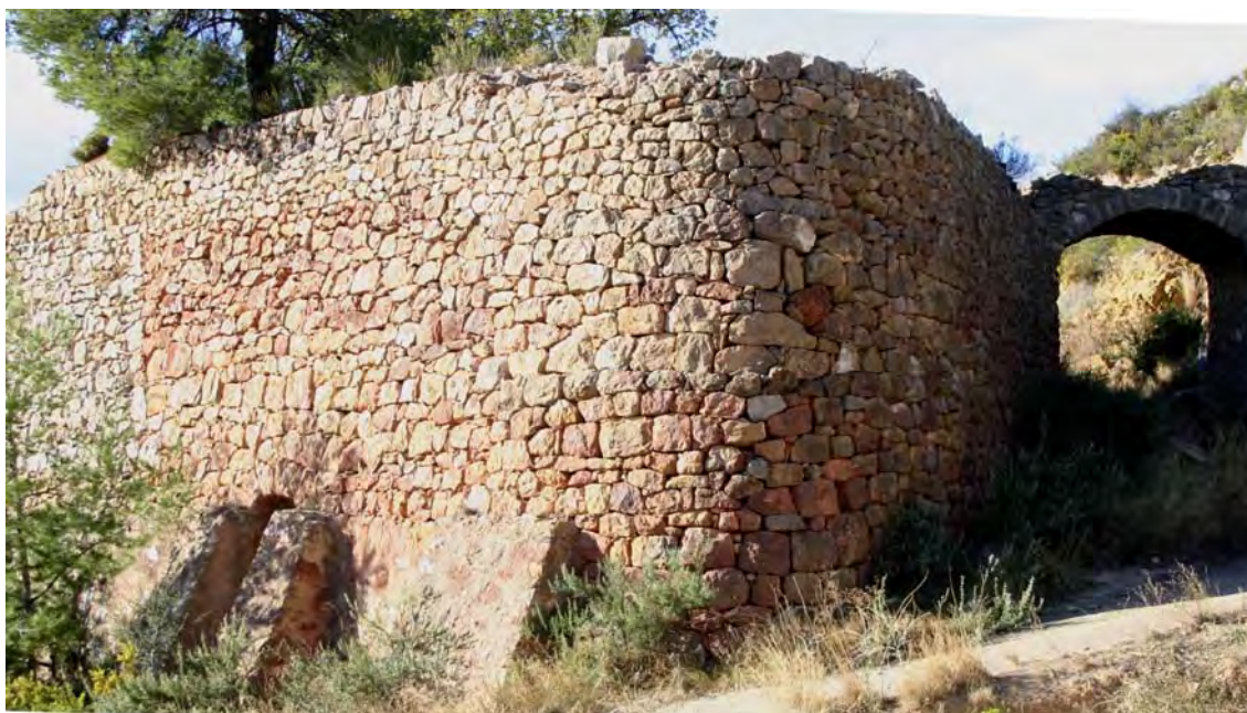
Fornes de ciment blanc, als Fornets (mines de Monterde), Cominells.
