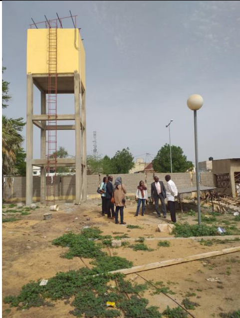
Avant cours Lycée des jeunes fille Ndjaména Château en construction
