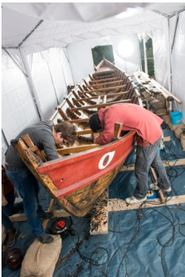
Chantier d'entretien du Gyptis © L. Roux, CCJ, AMU-CNRS
