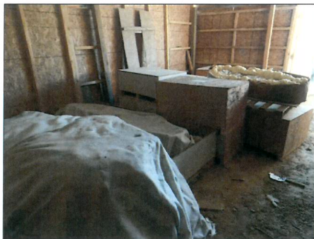
Fig 16. Vista general del material almacenado en obra.
