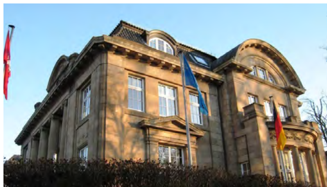
Construction de l'Institut de l'UNESCO pour l'apprentissage tout au long de la vie (UIL) à Hambourg. © UIL
