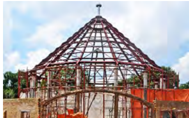
Partie surélevée de la structure
