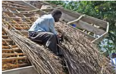
Pose de toit de chaume (tombes Wamara)
