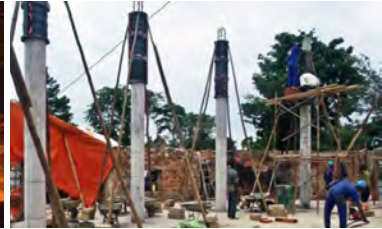
Construction de poteaux en béton
