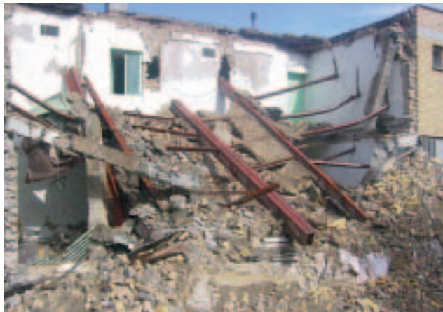
Des habitations se sont effondrées sur les personnes endormies au moment où le séisme a frappé
