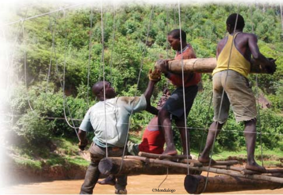
Esta pasarela construida en Rwanda en 2002 es uno de los modelos que inspiró la concepción del «puente listo para ensamblar»
