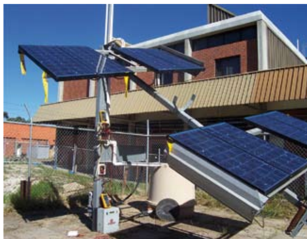
Construcción de un prototipo de mini red eléctrica en Indonesia el año pasado, asociando los transformadores de energía solar, eólica y una mini estación hidráulica con un generador diesel convencional, que abastecerá a las comunidades indonesias de energía y agua purificada
