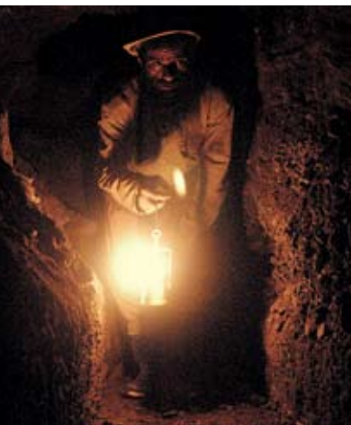
Житель Бама проверяет один из поврежденных кяризов после землетрясения в декабре 2003 г.
