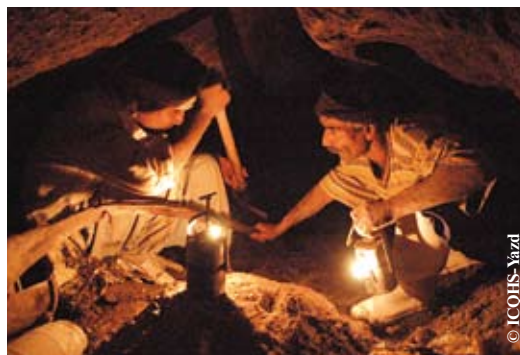
Dos obreros reparan uno de los qanats de Bam
