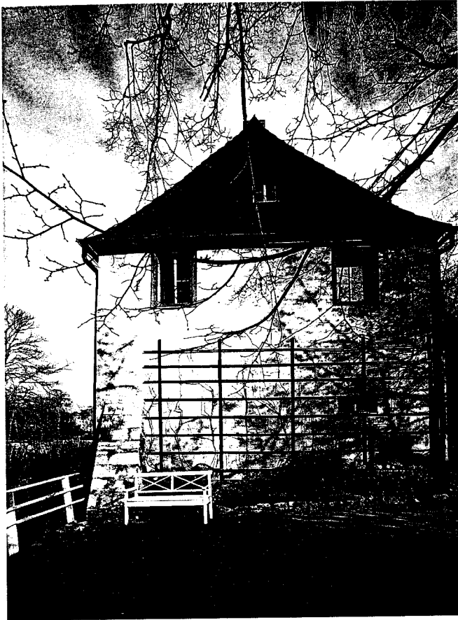
Abb. 323. Goethes Gartenhaus, Südfassade.
