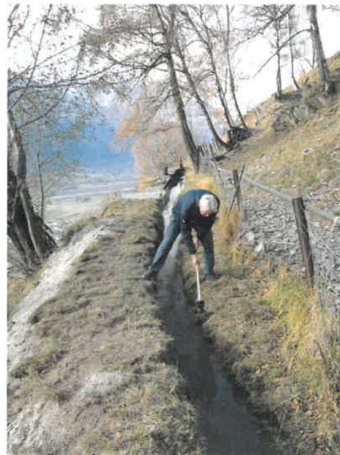
Travaux d'entretien à la Wyngartneri Employé communal
