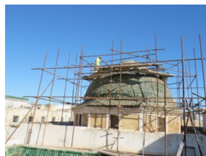
Stabilisation works. © Institut National du Patrimoine / Equipe de la Conservation de la Medina de Tunis
