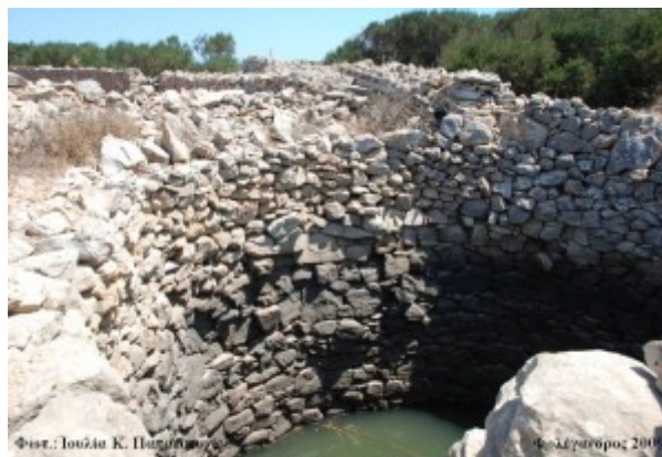
Φωτ.: Ιουλίτσα Κ. Παπακωνσταντίνου Πηγάδι μεγάλων διαστάσεων από Ξερολιθιά, για το πότισμα των ζώων και την άρδευση των παρακείμενων καλλιέργειών, στην ύπαιθρο της Φωλεγιάς.
