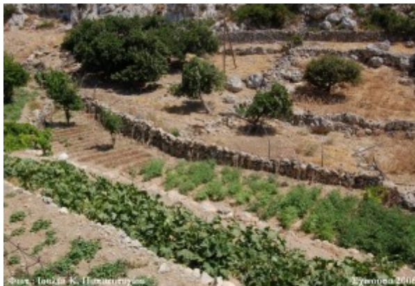
Περβόλι στην ύπαιθρο της Σιντούσας, διαμορφωμένο με αναβαθμίδες και χαμηλούς διαχωριστικούς γκρότες από Ξερολιθιά.
