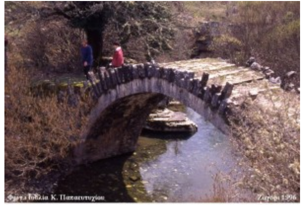
Φωτ.: Γούλια Κ. Παπαευσταθίου Γεφύρι στο Ζαγόρι, με στήθιο από ξερολιθιά και λιθόστρωτη επικάλυψη για τη δύσκολη ανθρώπινη ζωή.
