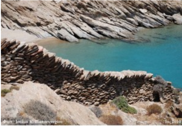
Φωτ.: Ιουλίτσα Κ. Παπακωνσταντίνου Διαχωριστικός τοίχος από Ξερολιθιά σε άριστη κατάσταση, για την οριοθέτηση οικοκτηριών στην ύπαιθρο της παραθαλάσσιας περιοχής της Ίου. Οι όρθιες σχιστόπλακες αποτρέπουν τη διάβρωση των ζώνων.
