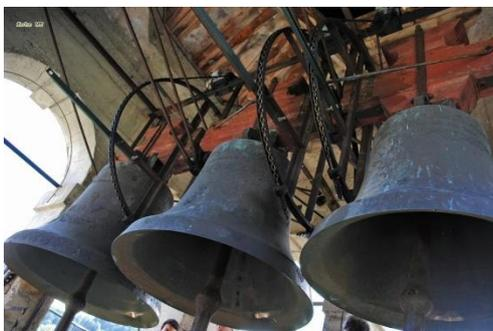
Figura 5. Vinaio, località in provincia di Udine. Esempio di “incastellatura” di campane in una struttura dai ceppi in legno. Il sistema di suono in cui sono montate le campane è il cosiddetto “slancio friulano”
