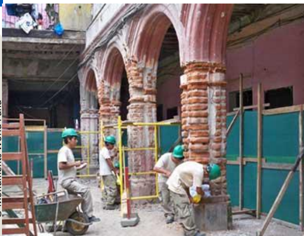
Obra de restauración
