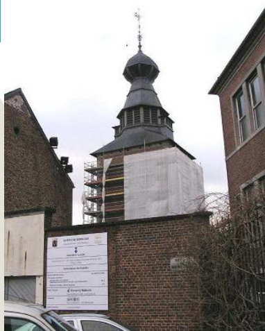
Le chantier de restauration des façades du beffroi
