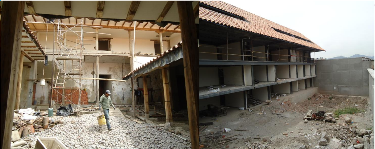
Obras en la calle Rafael María Arízaga
