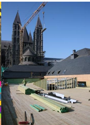
Le chantier du nouvel office de tourisme de Tournai
